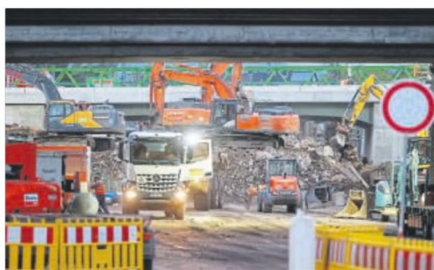
Brückenbau beim Rangierbahnhof Kassel: Was hier abgebrochen wird, kommt wenig später recycelt als Neubaumaterial an die Baustelle zurück.
