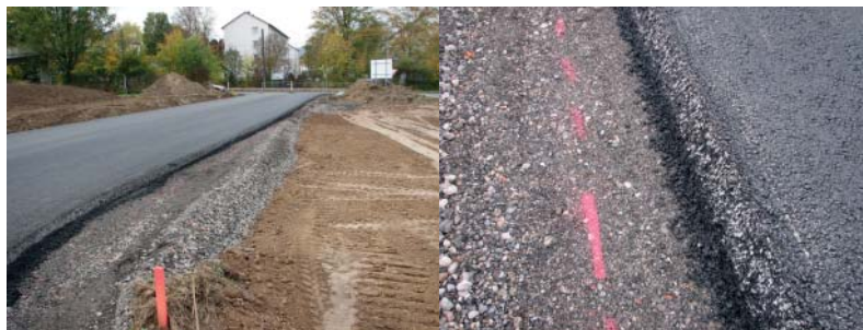
Abbildung 4 Einsatz von RC-Frostschutzmaterial unterhalb einem Asphaltbelag, Gewerbegebiet Thielenäcker in Kassel
