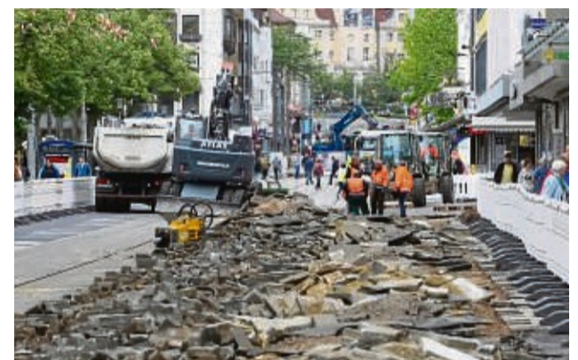
Aufbruch wird aufbereitet: Von den Bauarbeiten auf der Königsstraße wanderten einige tausend Tonnen ausgebaggertes Material zum Recycling.
